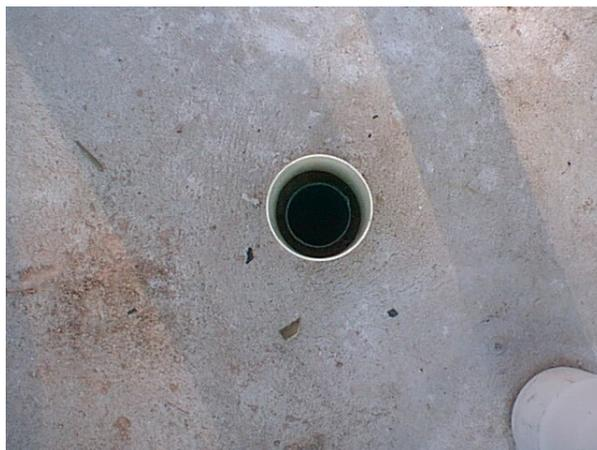
*Fotografía N°14: Construcción puntos de nivelación en profundidad.*
