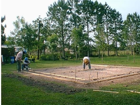
*Fotografía N°6: Montaje de armaduras.*
