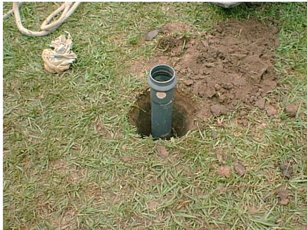
*Fotografía N°10: Montaje de camisa para protección del punto fijo.*
