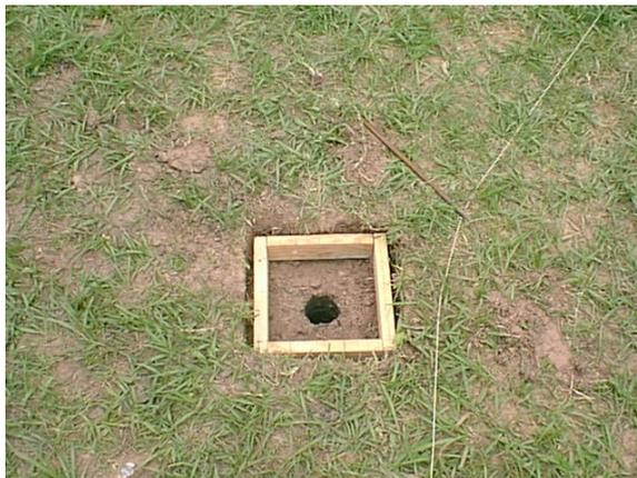
*Fotografía N°13: Puntos de nivelación externos antes de su hormigonado.*
