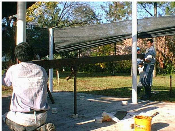
*Fotografía N°20: Hincado estático de tubos Shelby para extracción de muestras inalteradas.*
